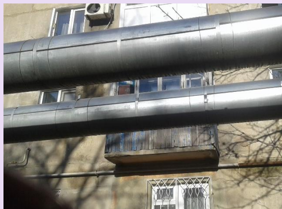
Фото 2 Тепловая изоляция трубопровода 2021 год
