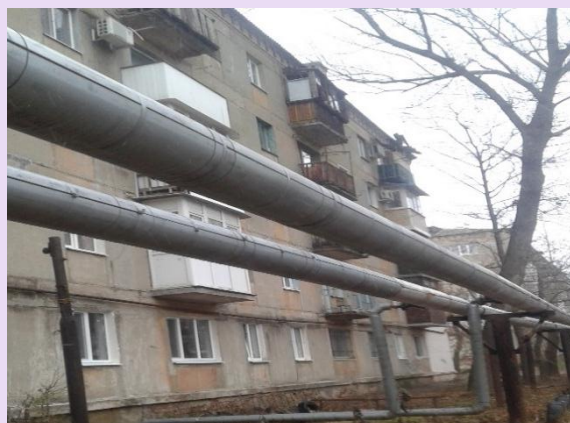
Фото 4 Участок теплотрассы 2021 год
