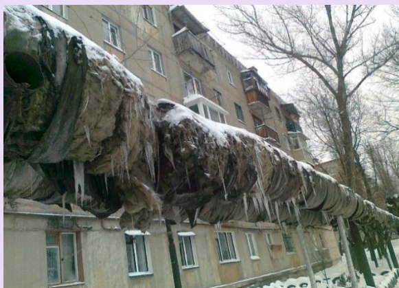
Фото 3 Участок теплотрассы 2014 год
