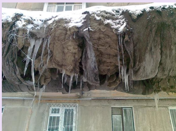
Фото 1 Тепловая изоляция трубопровода 2014 год
