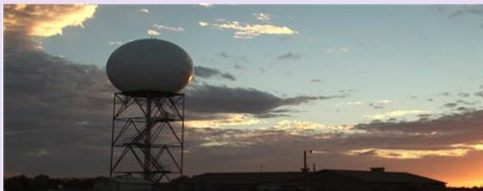
Рис.2 Доплеровские радары отправляют импульсы радиоволн для сканирования атмосферы
